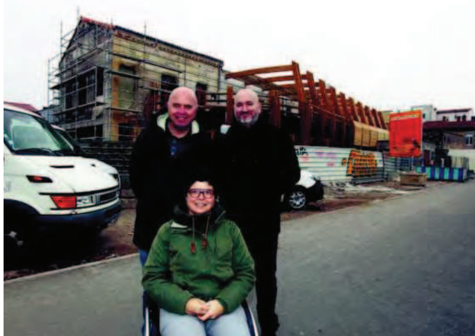
Pierre Maly, gérant, Arnaud Labodinière, chef cuisinier, et Amandine Tribbia, future directrice du restaurant, devant le chantier en cours aux Bassins à flot. PHOTO PHILIPPE TARIS
