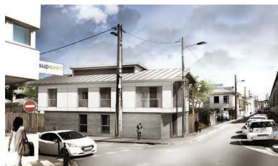
Le centre doit être construit à l'angle des rues de Doumerc, Louis-Braille et François-Daunes. Les travaux doivent commencer à l'automne. IMAGE DE SYNTHÈSE ARTHUR BARTHEROTTE ARCHITECTURE
